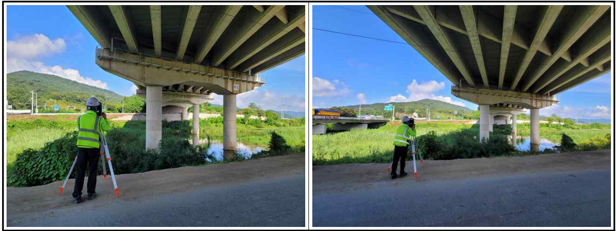
【사진 3.4.2】 측량작업 전경
