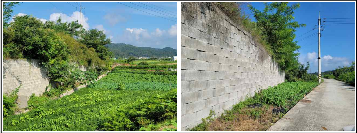
【사진 3.3.1】 지반, 기초부 전경
